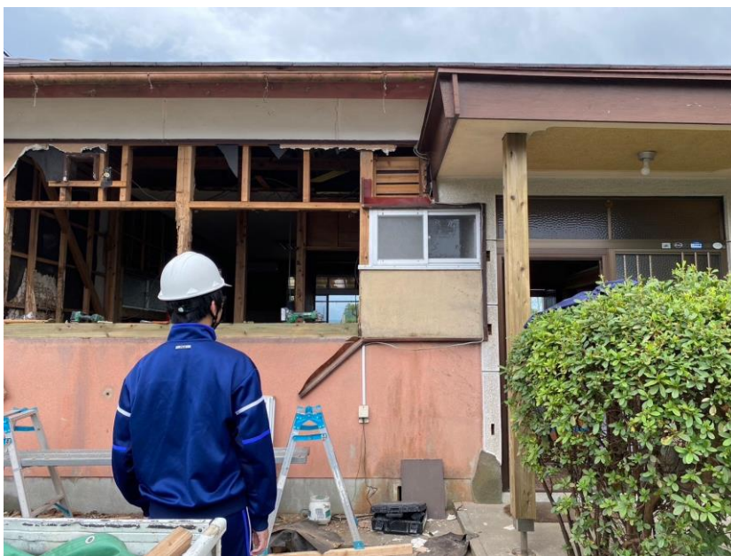
解体現場の見学
